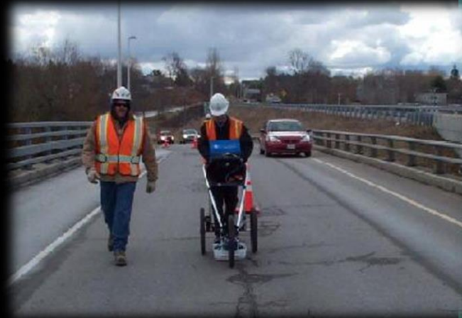
Παρακολούθηση καταστρώματος γέφυρας
